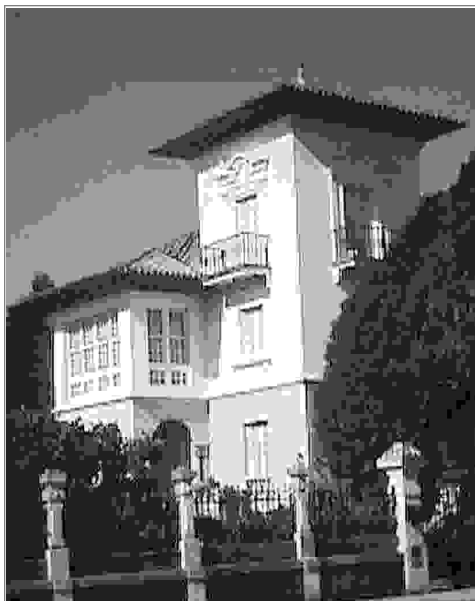
Torreón e galería.
