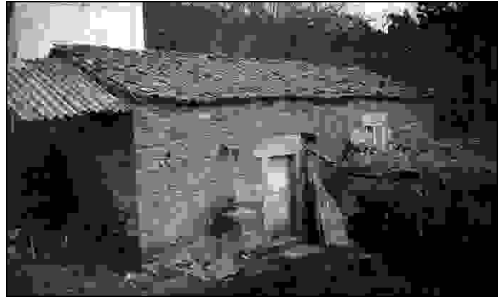
Fachada principal do muíño.
