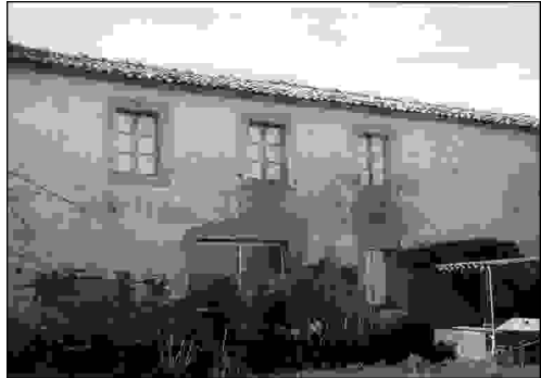
Fachada posterior da casa.
