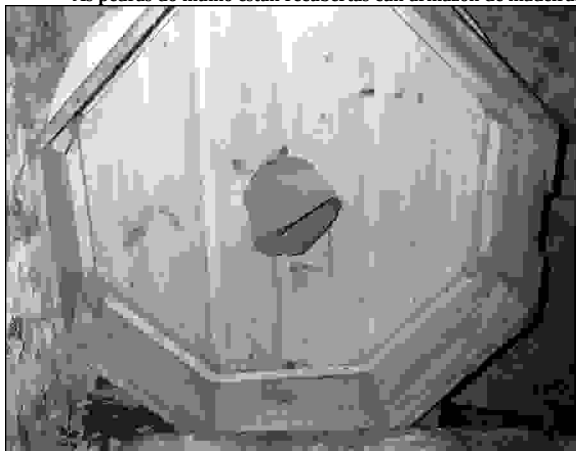
As pedras do muíño están recubertas cun armazón de madeira.
