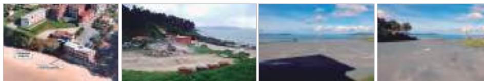
Antes, durante y después de la demolición del Anduriña y del Mar Molino
