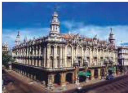
Pazo Social do Centro Galego, tal como se atopa na actualidade, construído entre os anos 1907-1915
