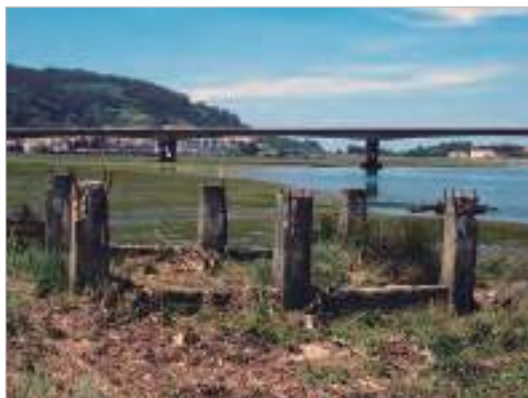
Pilares que sujetaban la tolva de la arena. Detrás, en el río, restos de la draga
