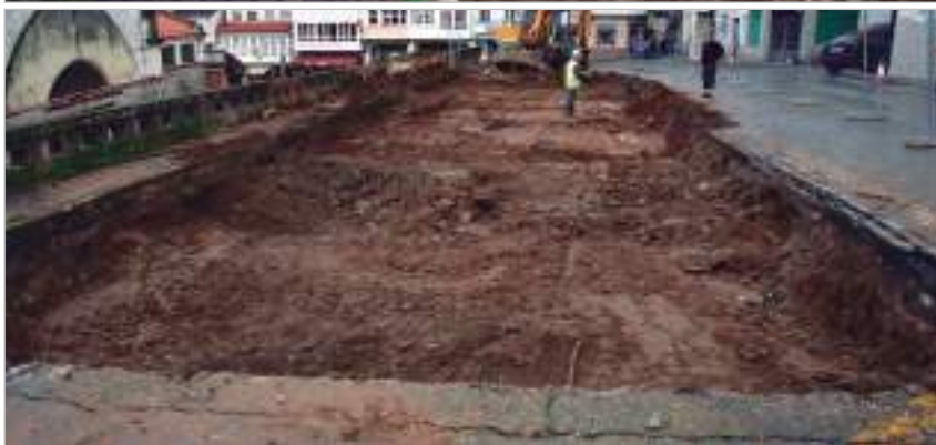
Inicio da segunda fase co traballo da pa retirando o pavimento e formigón até as estruturas
