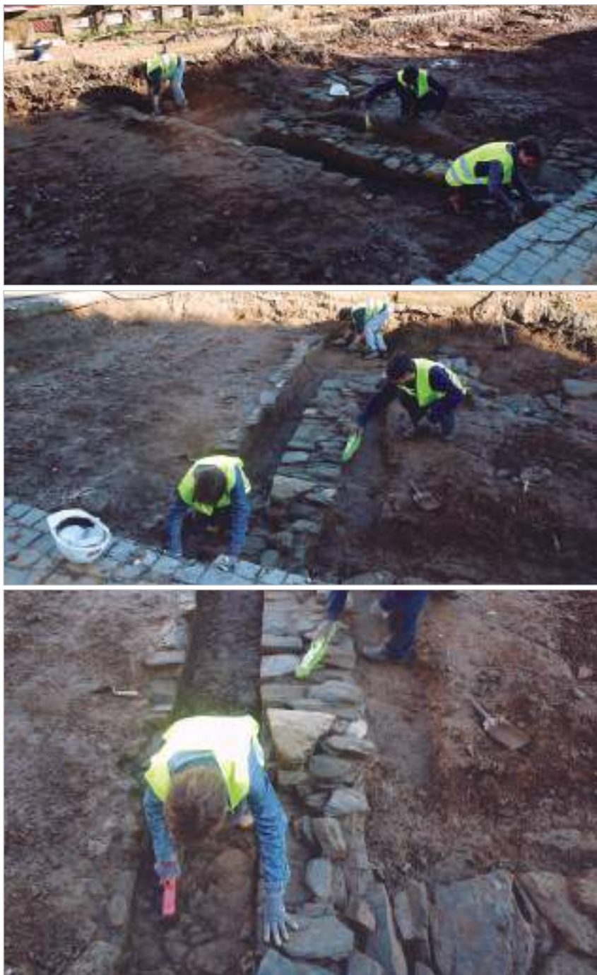
Escavando os muros da casa do labrador e das cortes, así como a canle
