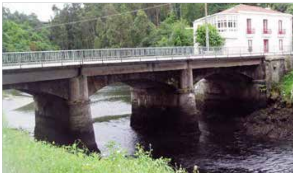
Actual Ponte do Porco
