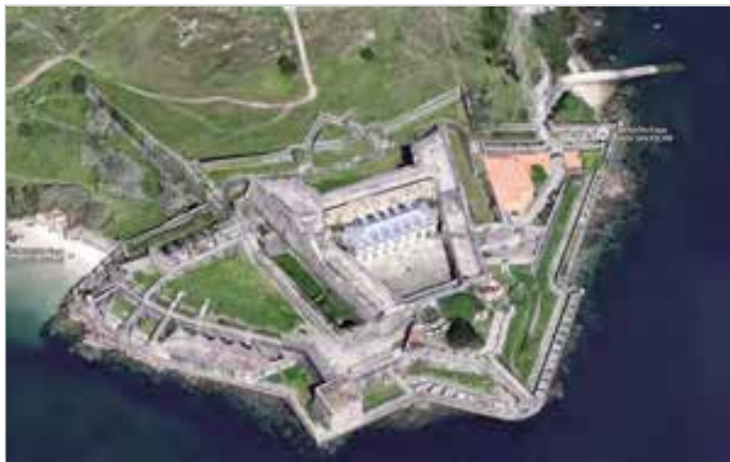
Vista aérea do castelo de San Felipe despois da rehabilitación da casa do Gobernador
