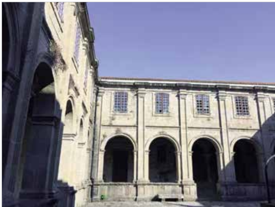
Claustro principal do mosteiro de Santa Catarina de Montefaro
