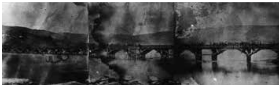
Ponte provisional de madeira
