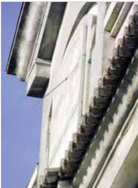
Forma e posición do gnomon polar de varilla
