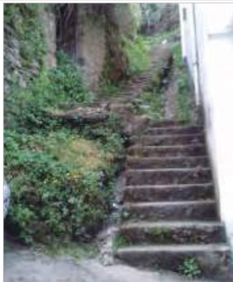
Escaleiras do Monumento
