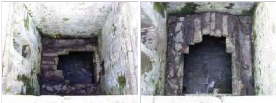
Figs. 69, 70. Estado do alxibe despois do baleirado: vistas cenitais sueste e nordés (dende o coroamento)
