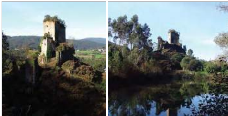
Figs. 6, 7. Perspectivas leste e nordés do castelo previas á intervención en 1ª fase
