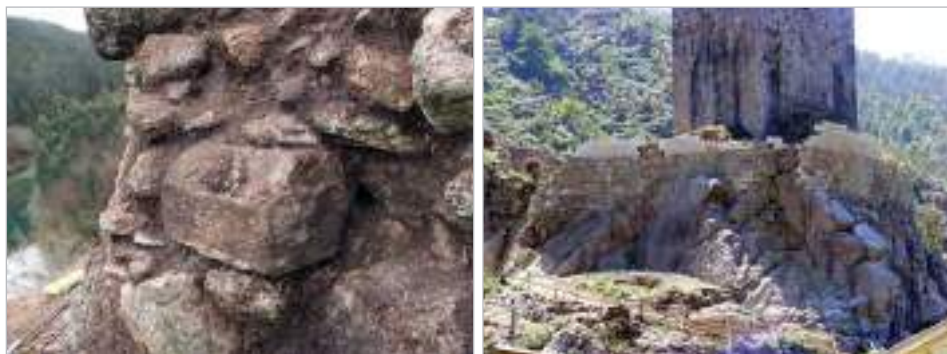
Figs. 52, 53. Doela da bóveda da torre reutilizada no recheo da camisa e aspecto da mesma ao remate da 2ª fase de intervención
