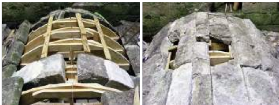
Figs. 76, 77. Proceso de remontado da bóveda do alixibe mediante o emprego de cimbra de madeira
