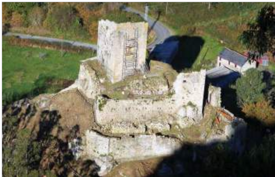
Fig. 29. Perspectiva sur do castelo previa á intervención en 2ª fase
