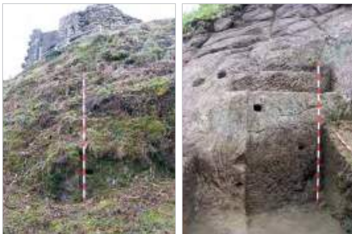
Figs. 36, 37. Sondaxe U.S.5, estado previo e final: paramento sur con batente da porta de acceso ao camiño
