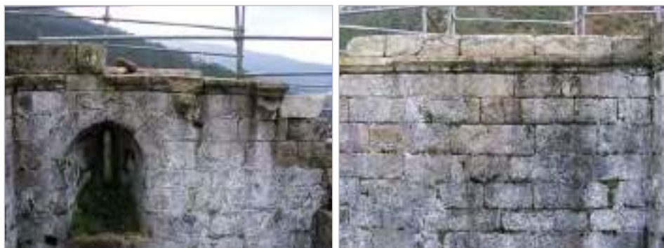
Figs. 61, 62. Traballos de limpeza do coroamento: paramentos suroeste (cornixa interior, ménsulas e seteira ST-0.3) e sueste (cornixa interna)
