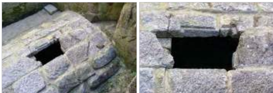
Figs. 78, 79. Anastilose da bóveda do alixibe: vista parcial (área nordés) e detalle da boqueira orixinal
