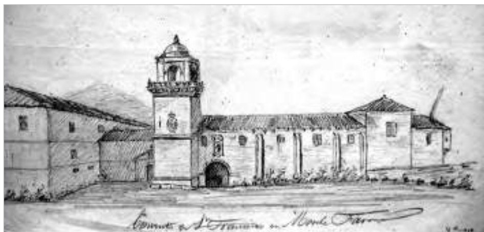
Convento de Montefaro. Vicente Pueyo (c.1859)
