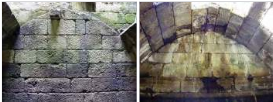
Figs. 74, 75. Vista interior dos paramentos nordés e suroeste do alixibe antes da anastilose
