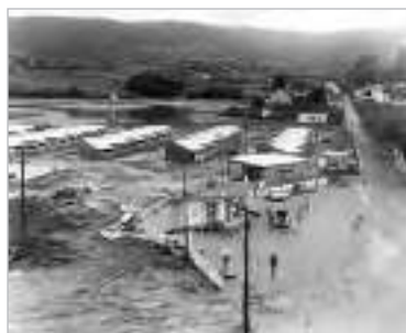
Comezo das obras
