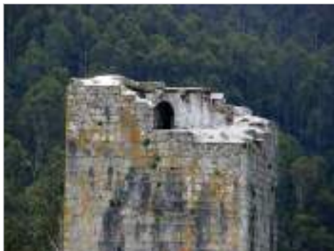
Fig. 65. Coroamento da torre xa impermeabilizado. Vista nordés
