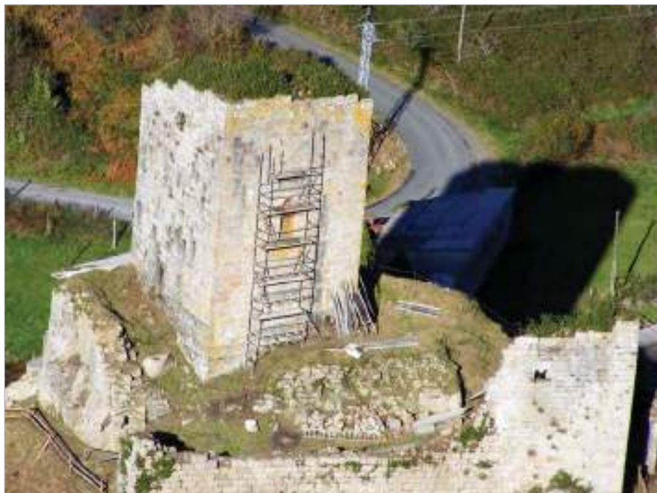
Fig. 54. Perspectiva sur da torre da homenaxe previa á intervención da 2ª fase
