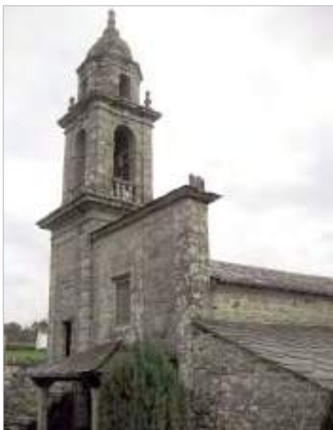
Vista parcial das fachadas sur e oeste
