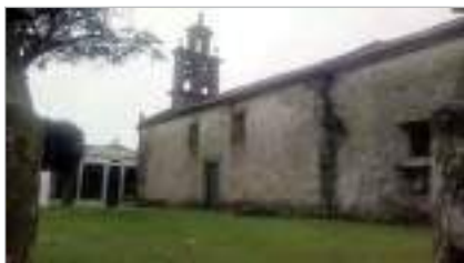
Fachada meridional da igrexa
