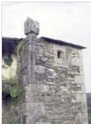
Detalle do reloxo sobre o esquinal
