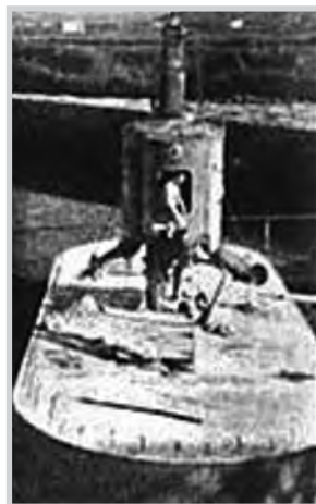
Figura 10: Imaxe da época dun caixón coa esclusa na parte superior.
