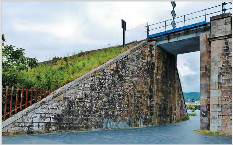
Figura 19: Vista actual do muro e do paso do Areal
