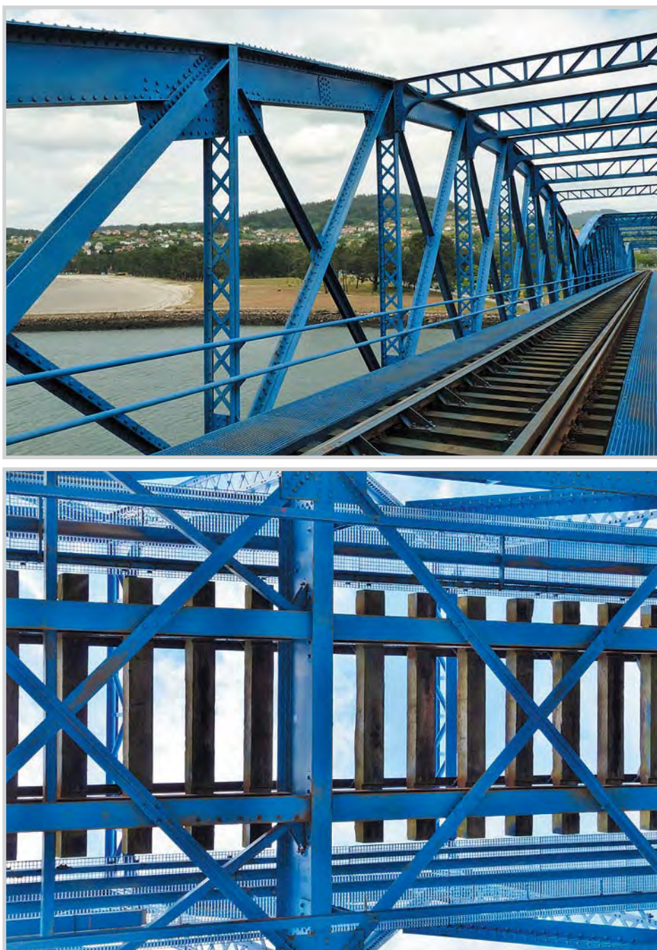
Figura 31: Vista de celosías laterais da ponte e riostas superiores (sup) e celosías inferiores (inf)
