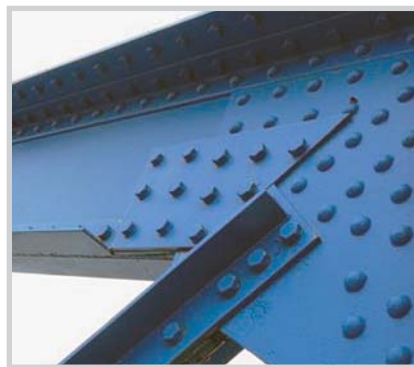
Figura 37: Vigas verticais onde se poden ver os porlóns do remachado (esq) e zona de remaches 64 (der)
