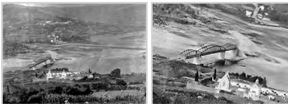
Figura 29: Derradeira fase de construción, onde se aprecian as pontes provisionais baixo a ponte. Detalle
