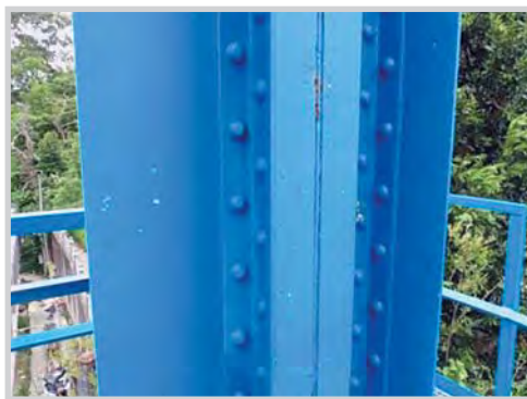
Figura 37: Vigas verticais onde se poden ver os porlóns do remachado (esq) e zona de remaches 64 (der)
