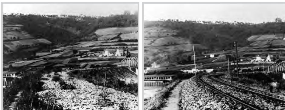
Figura 42: Tendido da vía na zona superior do terraplén do Areal de Cabanas
