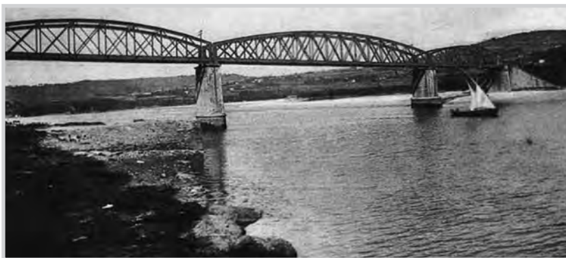
Figura 25: Imaxe da ponte rematada co piar 1º en primeiro plano
