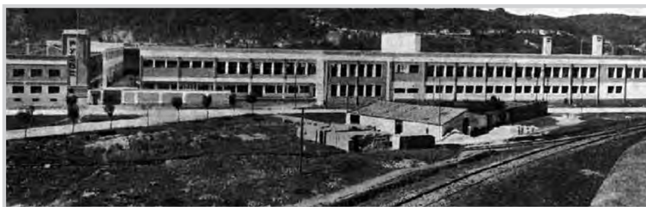
Instalacións de Pysbe no peirao de Ferrol 1945
