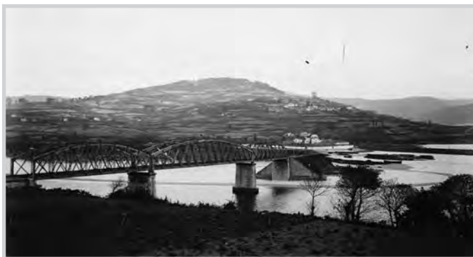
Figura 43: Ponte rematada dende Pontedeume
