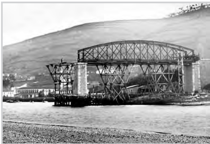
Figura 11: Construción do treito metálico lateral esquerdo
