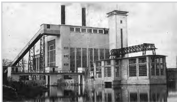
Central termica Calvo Sotelo
