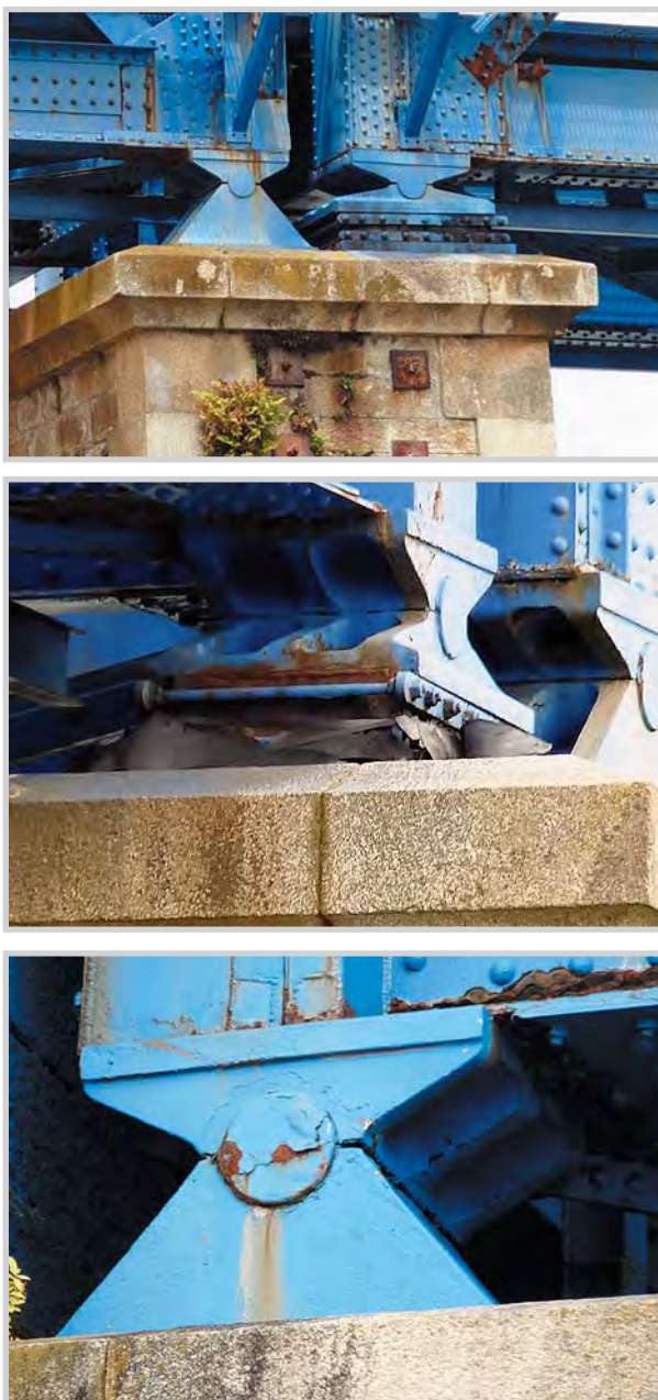
Figura 35: Apoios fixo (1º e móbil (2º e 3º) no piar 1º e asentado dos mesmos
