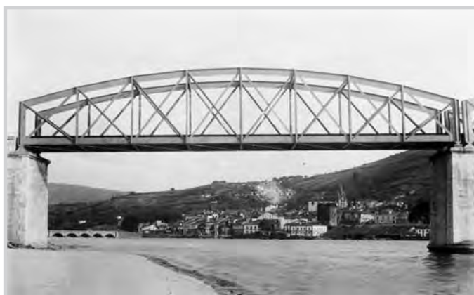
Figura 34: Treito dereito completamente rematado
