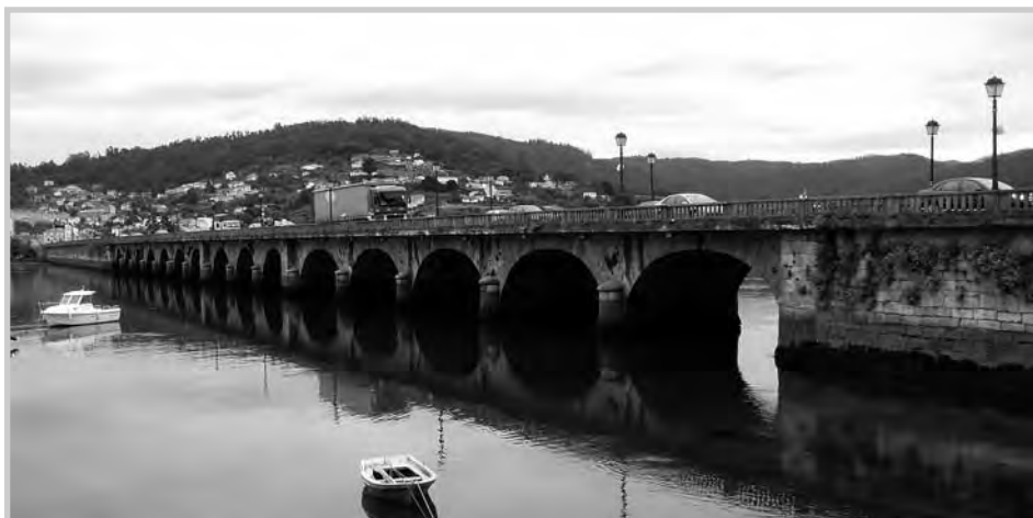
Actual ponte de pedra eumesa
