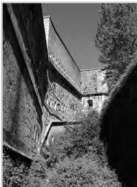
FIG 10: Fachada exterior de la galería aspillerada (desde el foso)
