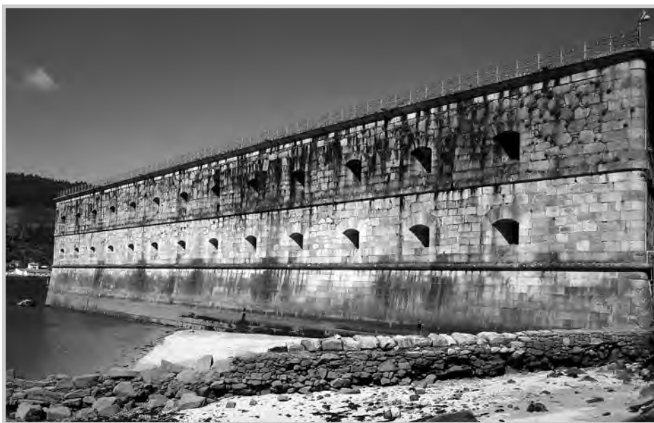
FIG 4: Batería de frente
