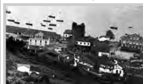
Fig.28: Vista desde la ladera del monte Bremao, h. 1925, fachada Sur
