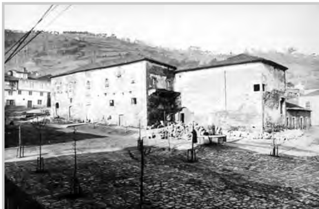
Fig.27: Vista desde la Plaza del Conde en 1918, fachada Este
