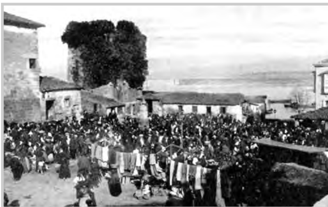
Fig.13: Imagen anterior a 1911 del conjunto del Palacio Fortaleza con sus dependencias anexas
