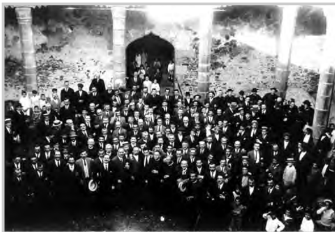
Fig.20: Vista del ala norte del patio, con sus características columnas y el arco conopial de ingreso a la escalera principal. (h. 1920)
