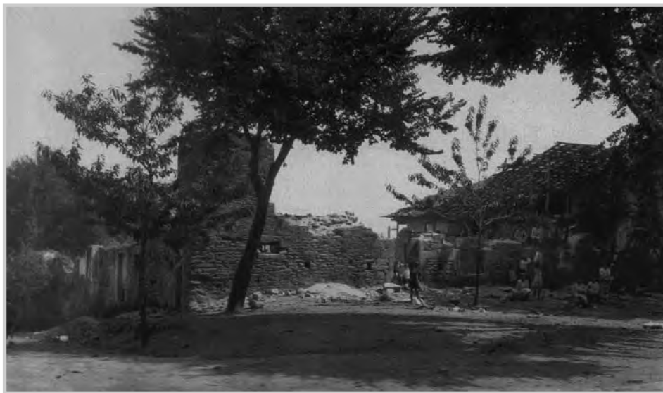
Fig.60: Fachada Sur demolida.
