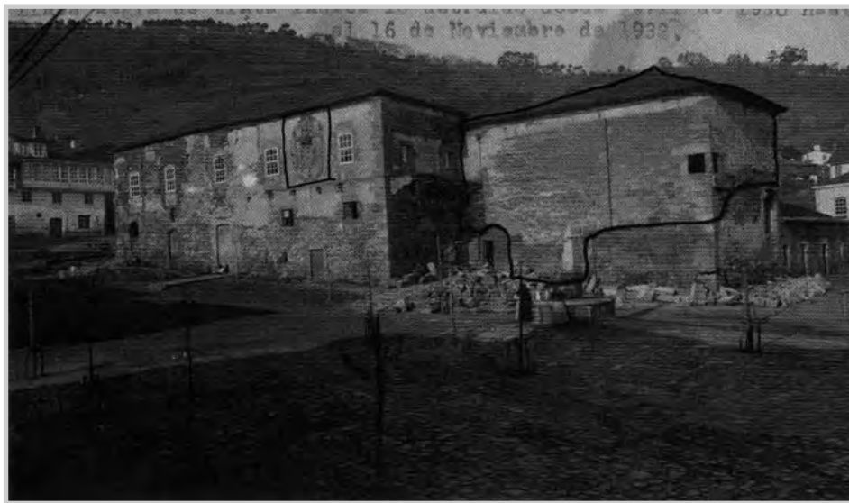
Fig.58: Fachada este del Palacio, en la que se remarcan las partes demolidas “Foto hecha en 1918. La línea negra de tinta indica lo destruido desde Abril de 1930 hasta el 16 de Noviembre de 1932”
