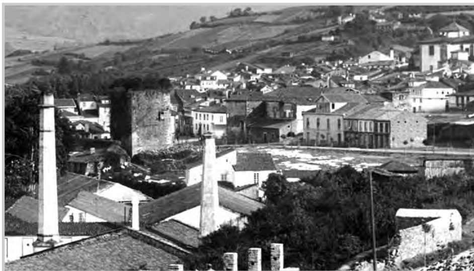
Fig.29: Vista desde la carretera de la Estación, h. 1925, fachada Norte
