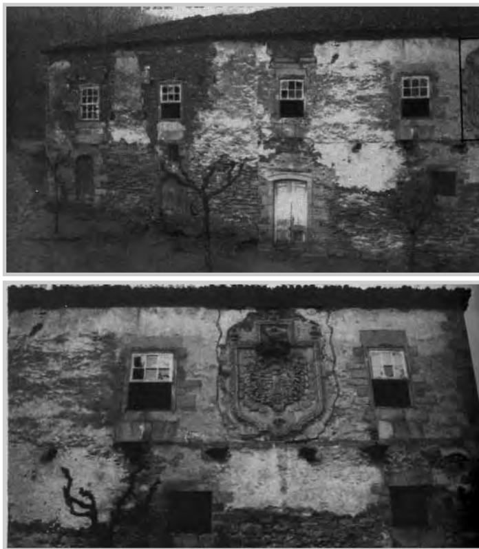
Fig. 56 y Fig. 57: Imágenes tomadas por Alejandro Ferrant en 1930 para informar acerca del estado del Palacio
