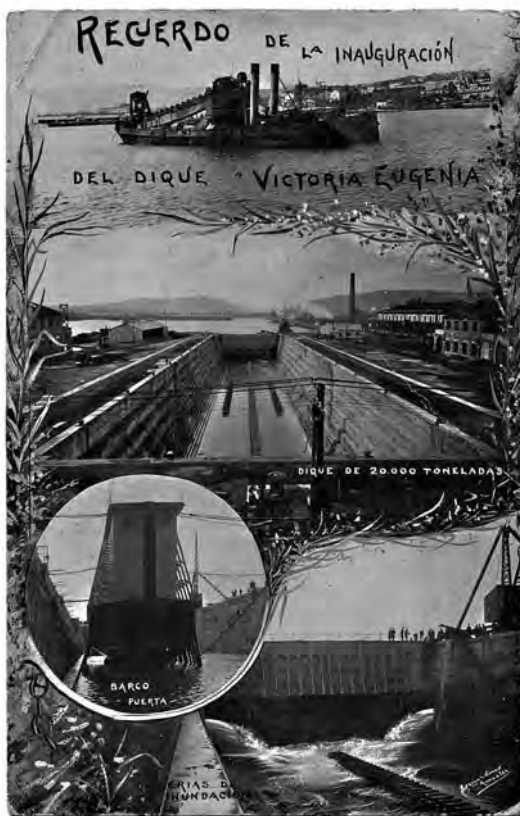
Novas infraestruturas no Arsenal de Ferrol construídas pola empresa Jackson, subcontratada por Vickers. ARQUIVO DA REAL ACADEMIA GALEGA
