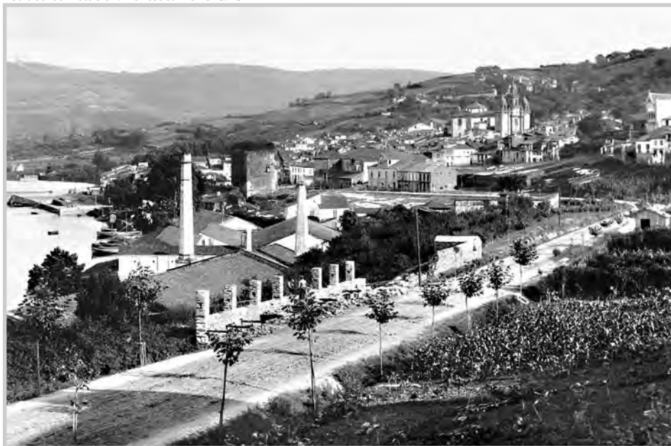
Estrada da Estación. Pontedeume 1913/15
