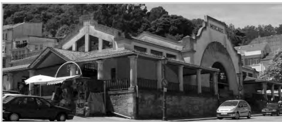
Figura 10. Vista del Mercado Municipal de Pontedeume.
