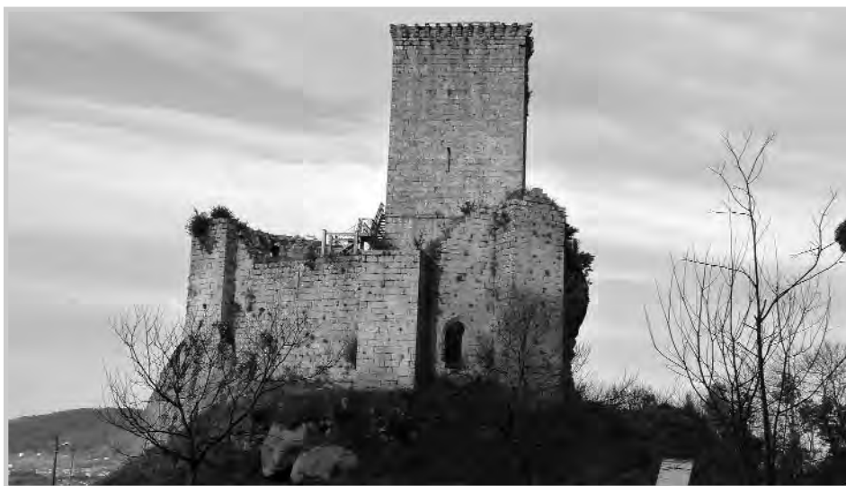
Foto 23: Torres defensivas para flanqueo de la puerta y cortina. Foto J.L.H.
