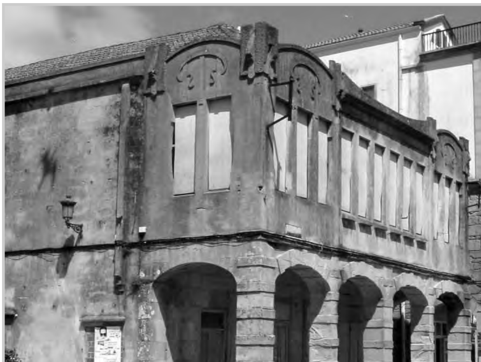
Figura 5. Vista parcial del antiguo cine París , avenida de Castelao, 97, Muros.
