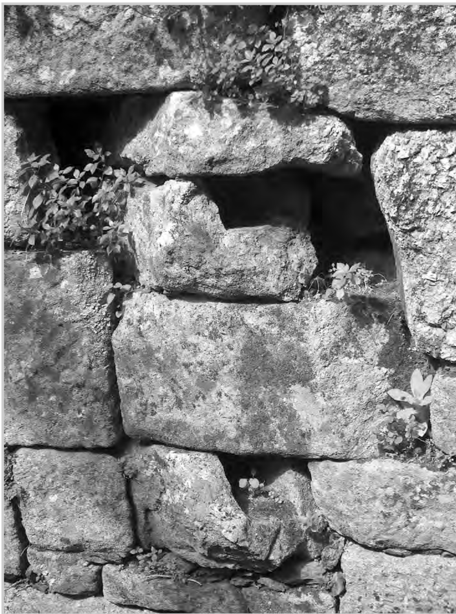
Foto 20: Alojamientos por donde corren los alamares, que impiden la apertura de la puerta por el ariete. Foto J.L.H
