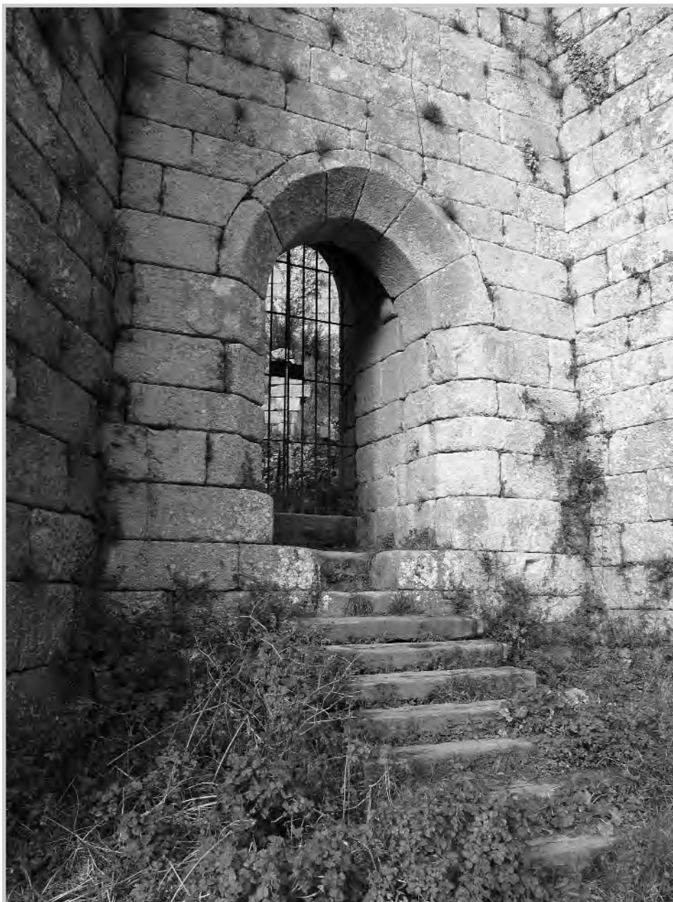
Foto 17: Puerta vista desde fuera. Foto J.L.H
