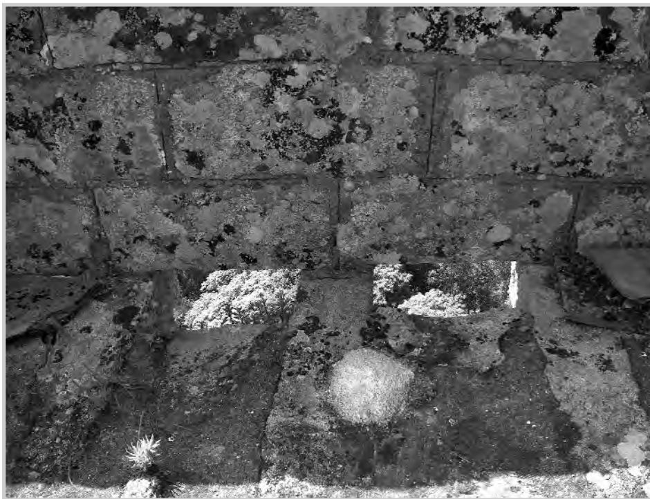
Foto 14: Matacanes que se conservan en el castillo. Foto José López Hermida
