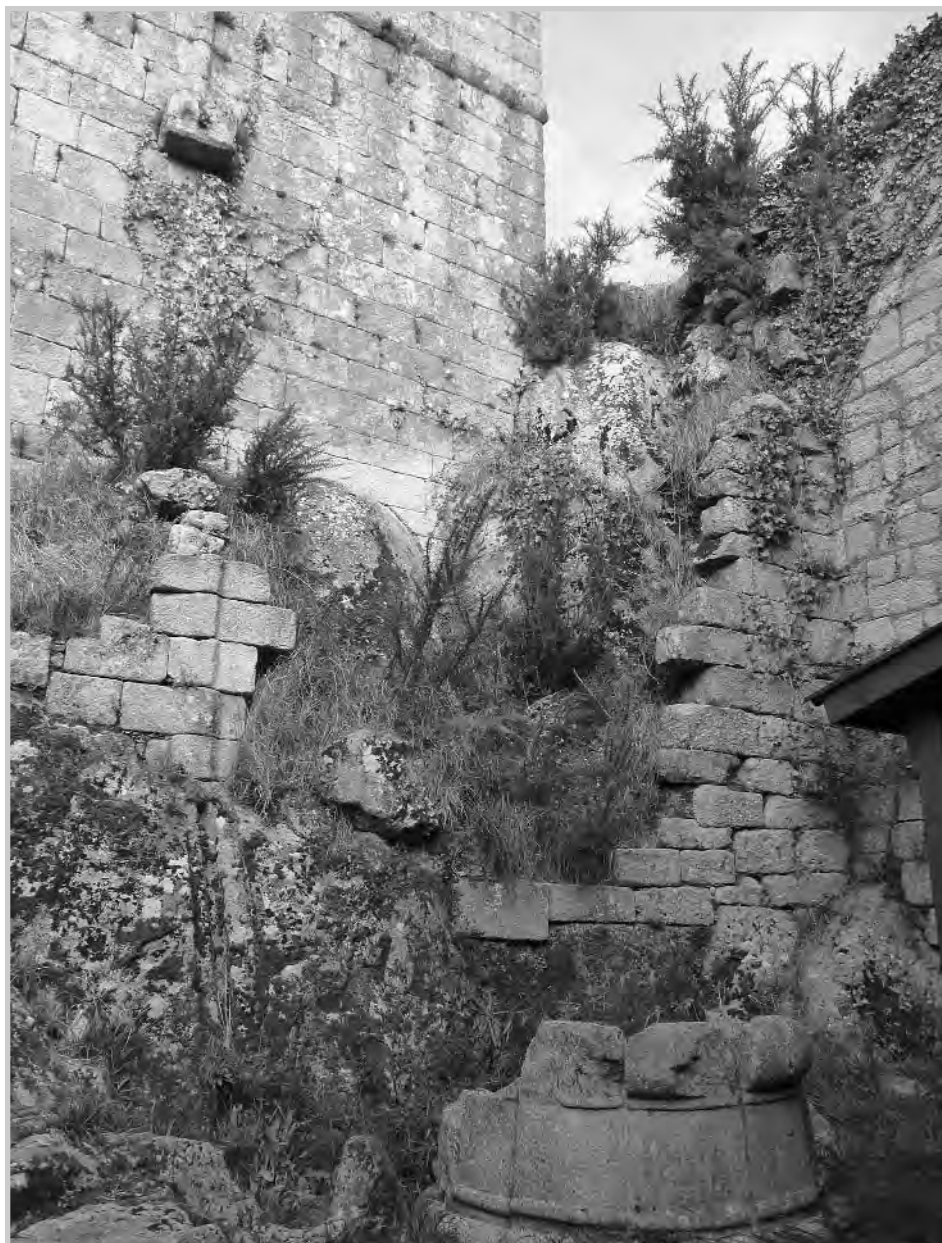
Foto 15: Conducción del agua y boca de la cisterna. Foto J.L.H.
