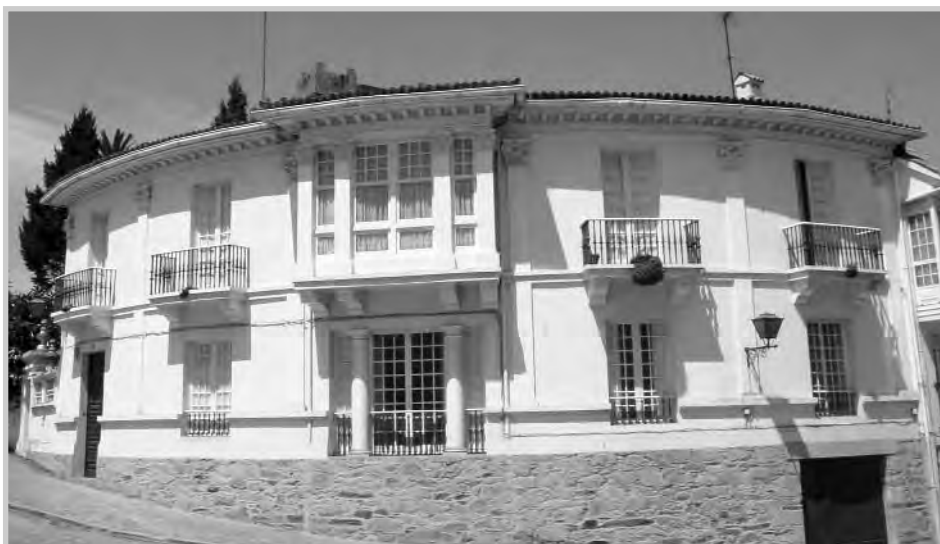
Figura 2. Edificio sito en praza do Conde, 10, Pontedeume.
