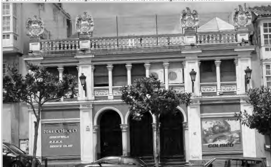
Figura 4. Fachada principal del antiguo Coliseo García Novoa , rúa San Agustín, 20, Pontedeume.
