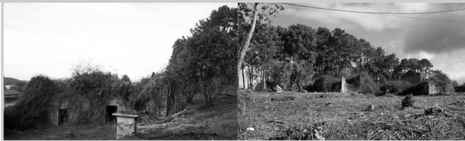
Ilustración 9. Estado actual do casal da Arbosa
