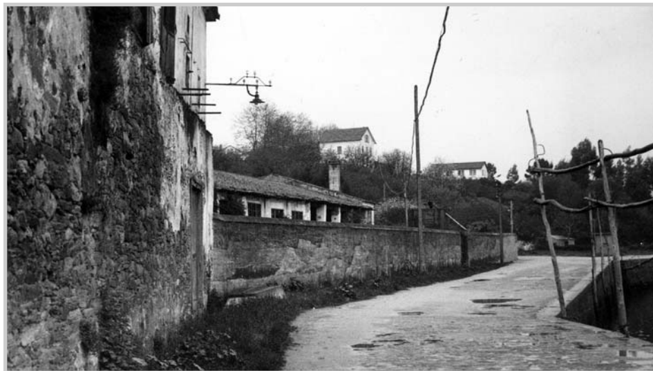
A fábrica de Curtidos “La América” pouco antes da súa demolición
