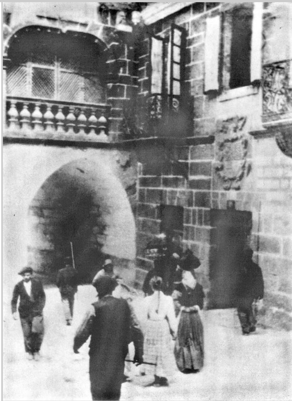
Figura 5: Puerta del Puente vista desde dentro de la villa.
