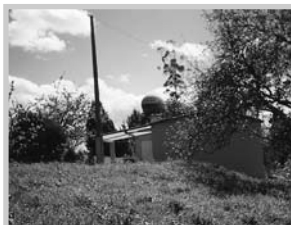
Dous tipos de depósito que permiten que a auga, a través dunha bomba eléctrica, chegue con forza ás billas.
