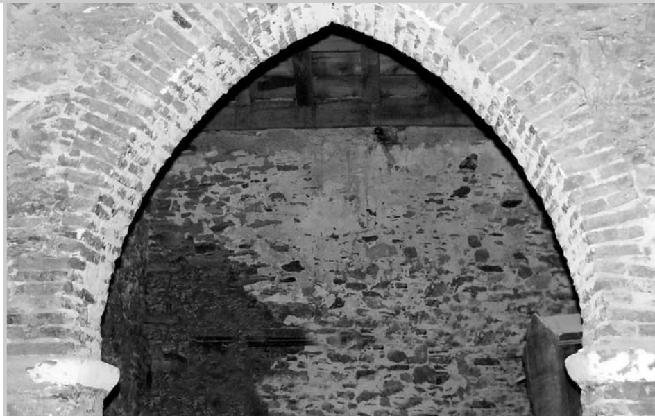
Vista del arco triunfal ojivalizado de un primitivo arco de herradura. Santa Comba, Cobas (Ferrol).
