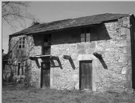
Casa de pedra abandonada en Xestoso. Aínda se aprecia a estrutura que sostíña a solaina, hoxe desaparecida.
