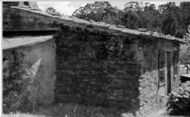
Modelo de caseto de planta baixa, na actualidade semirrestaurado. O tamaño do forno semicircular que sobresaen nun dos seus muros laterais, dá-nos unha idea da dimensión que pode ter no interior a lareira, como centro do fogar campesiño.
