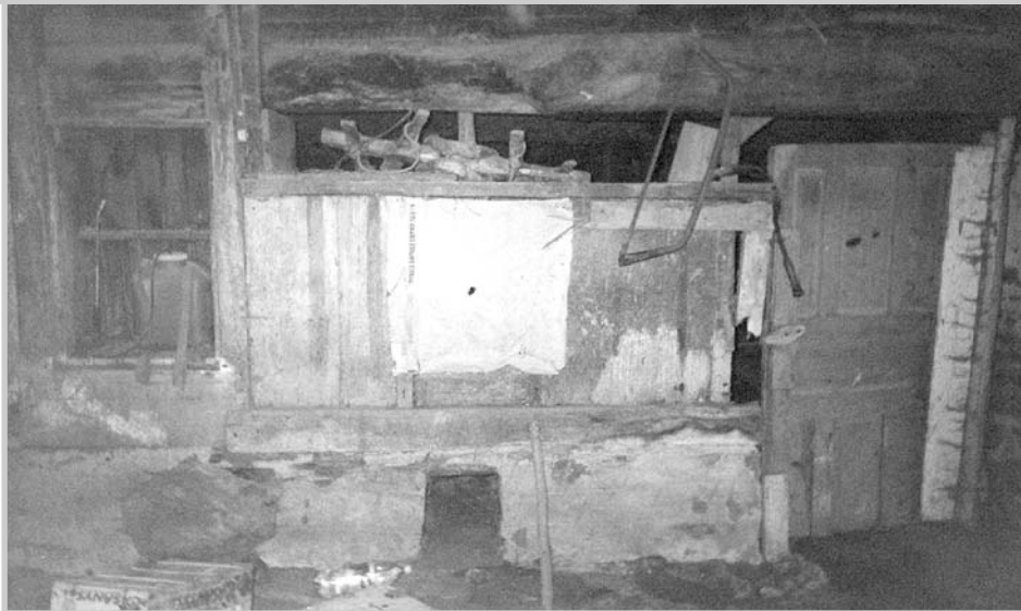
Na imaxe vense, de esquerda a dereita, os estantes no muro onde se colocaba a mesa de alzar, hoxe desaparecida; a ventá dos "baños", oculta tras un saco de plástico e a porta coa corte. Na parte inferior aparece o "poleiro", un pequeno espacio cuadrangular.
