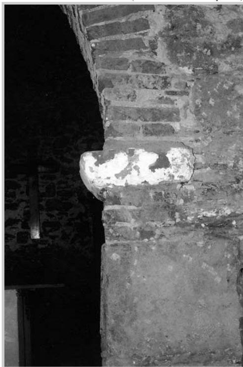
Vista del arco triunfal ojivalizado de un primitivo arco de herradura. Santa Comba, Cobas (Ferrol).
