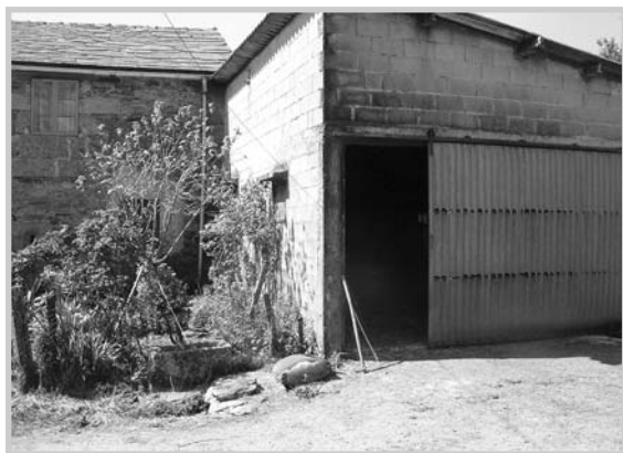
A construción de bloques pegada á vivenda tradicional de pedra constitúe o espazo ocupado polo gando vacún. Este modelo é frecuente no medio rural galego.
