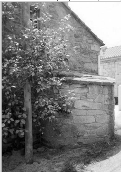
Forno nunha casa da parroquia de Torres (Vilarmaior).
