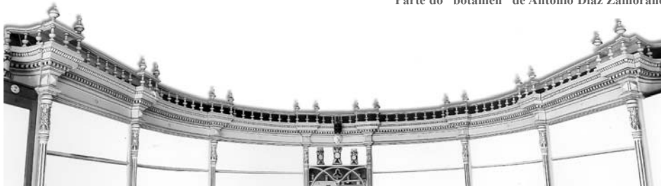
Detalle da balaustrada con columnas, realizado en 1904.
