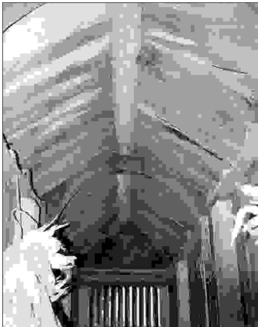
Detalle interior cámara.
