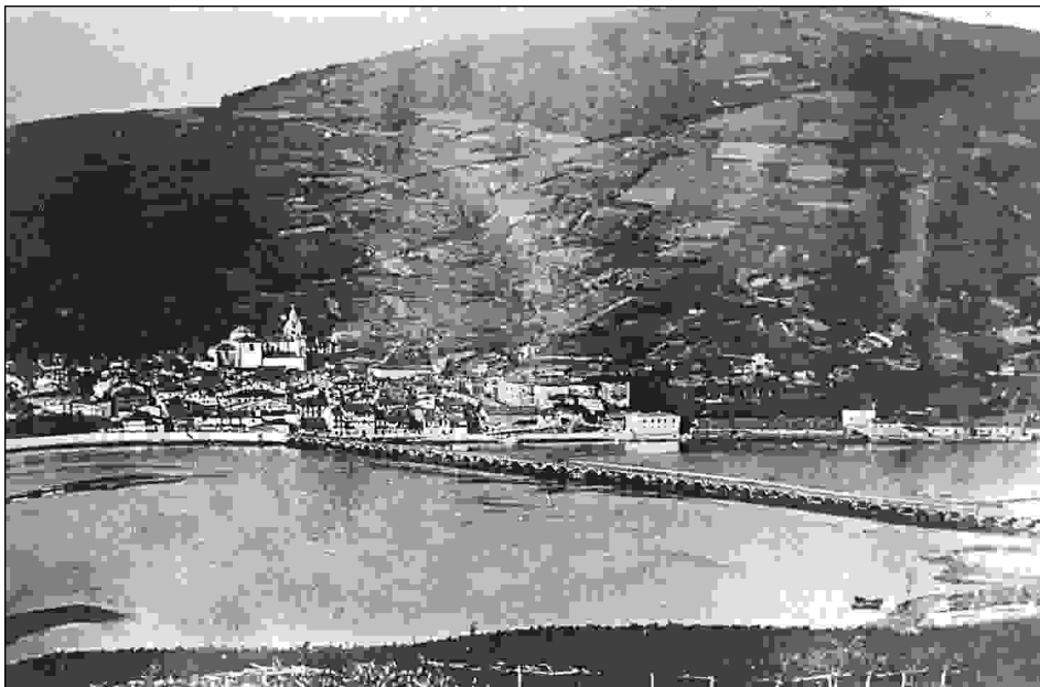
Foto 2: Ponte de Madeira 1866/7.
